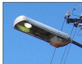
Obr. 1 Poškodenie optickej časti svietidla
