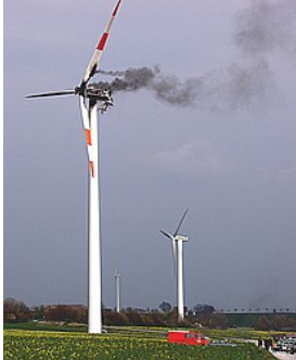
Obr. 4. Veterná elektrárňa po zásahu bleskom
