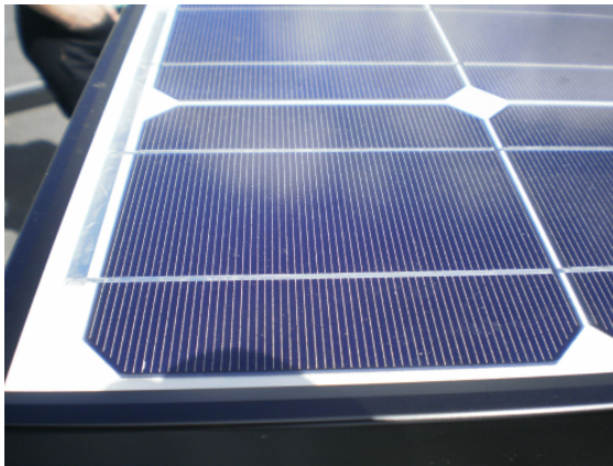
Obr. 3. Pohľad na monokryštalický FV panel osadený v externej časti laboratória
