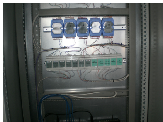
Obr. 2. Koncentrátor údajov nameraných veličín z fotovoltických komponentov
